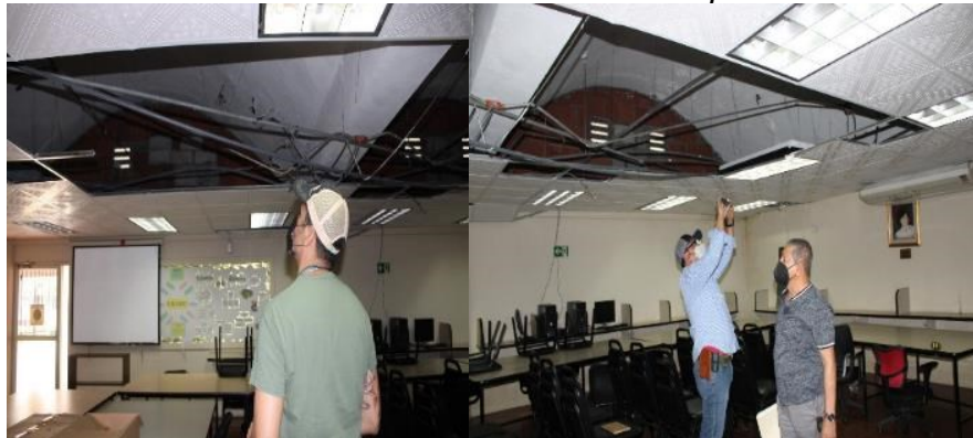
Vistas del techado interno de la Biblioteca especializada Idania Fernández
