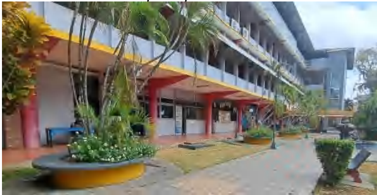
Figura 4. Fachada del edificio principal
