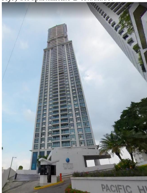
Figura 2b. Fachada del edificio Elite 500.
