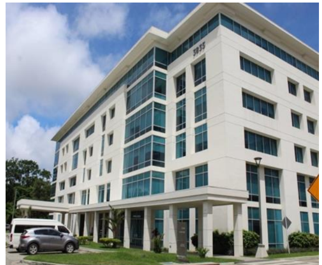
Fig. 1 Vista del edificio estudiado: edificio 3835 del Business Park, en Panamá Pacífico.
