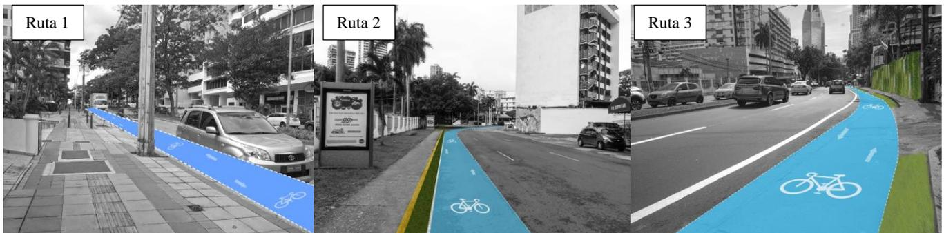
En el caso de la ruta 3 (av. Manuel Espinoza B.) se determinó el uso de un carril de estacionamiento como Ciclocarril. Para un diseño más económico se plantea una ciclorruta pintada separada del auto por barras de confinamiento [2], estructuras horizontales colocadas al borde de todo el carril que ayudan a tener un límite de seguridad entre el auto y la bicicleta
