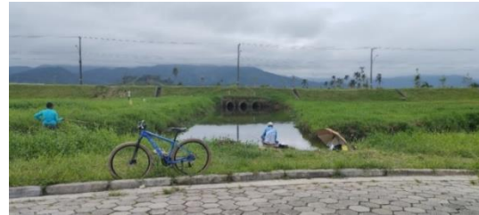
Figura 8: Bueiro 3 e a presença de pescadores no local (Elaborado pelo próprio autor, 2023).
