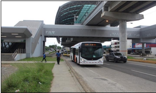
Figura 5. Estación del metro de Panamá Hospital del Este.
