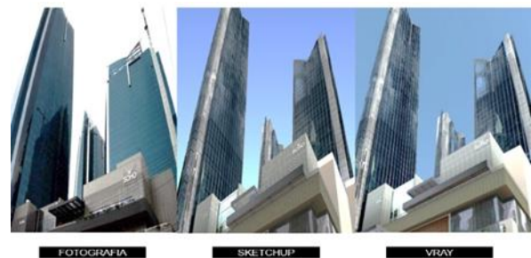
Fig. 7 Comparación de la foto tomada en sitio con modelado geolocalizado Edificio Soho Mall.
