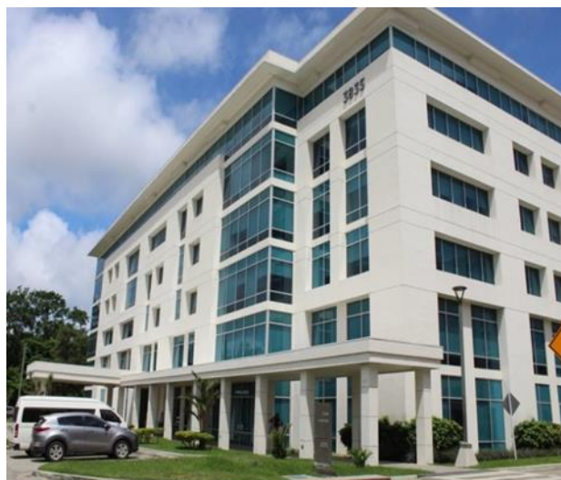
Fig. 1 Vista del edificio estudiado: edificio 3835 del Business Park, en Panamá Pacífico.
