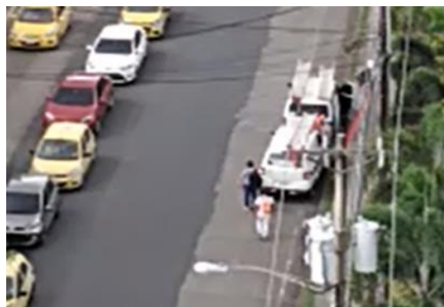
Figura 5. Foto de los carros de la empresa de servicios eléctricos que, a las 12:28 p. m., se estacionaron contiguo a la acera A de la UP.
