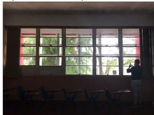
Figura 4c. Vista de la ventana del salón 7. Se observa que los vidrios de la parte inferior izquierda está pintados de blanco.
