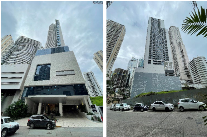
Figura 7. Vista Frontal y Lateral derecha del edificio.
