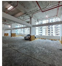
Figura 4. Vista interior de la fachada frontal.
