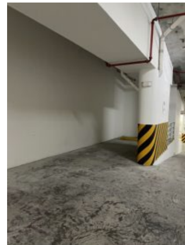
Figura 15. Vista del I0 en el nivel 500
