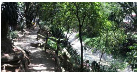
Figura 20: Drenagem com vegetação circundante e caminho para pedestres (Francisco Fabbro Neto, 2023).
