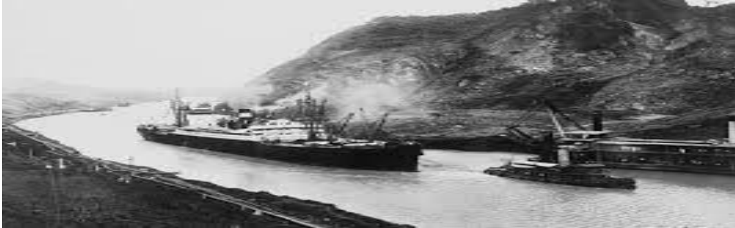
Figura 1. Construcción del Canal de Panamá
