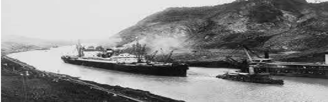
Figura 1. Construcción del Canal de Panamá
