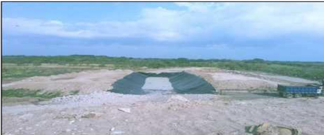
Nota. Instalación de la Geomembrana Impermeable dentro del relleno controlado del Jobo de Antón Fuente: AAUD 2014.
