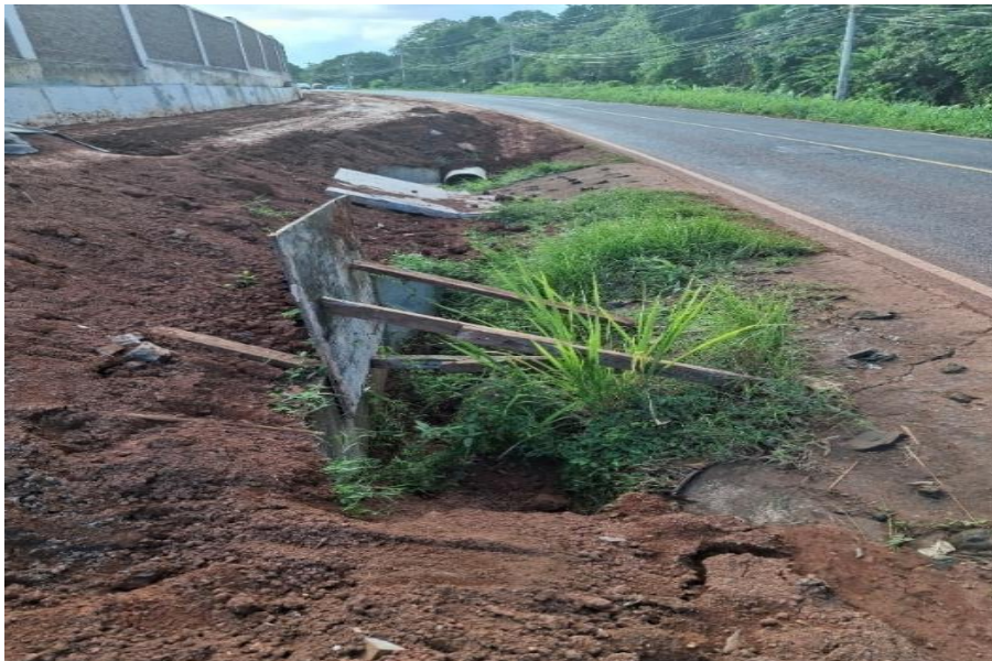
Figura 6. Alcantarilla cerca del muro
