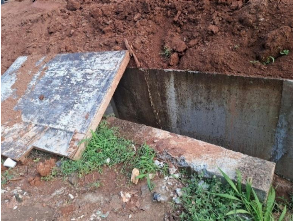
Figura 7. Área de Excavación para el Cabezal
