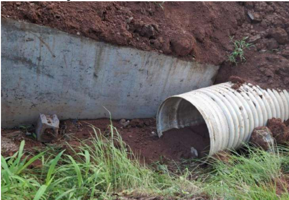
Figura 8. Salida de desagüe
