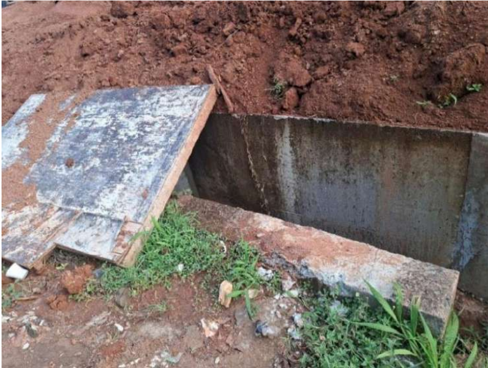
Figura 7. Área de Excavación para el Cabezal
