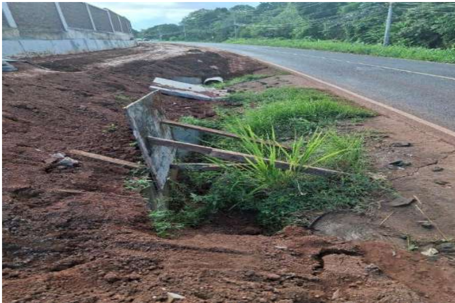
Figura 6. Alcantarilla cerca del muro
