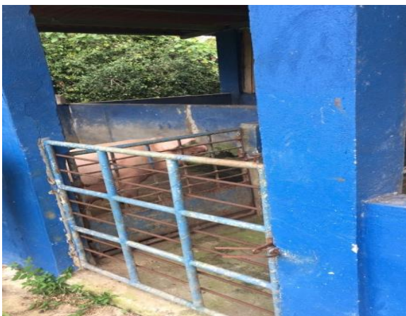
Figura 14. Casas de cementos para ganados. Fuente: fotos tomada por la autora/investigadora
