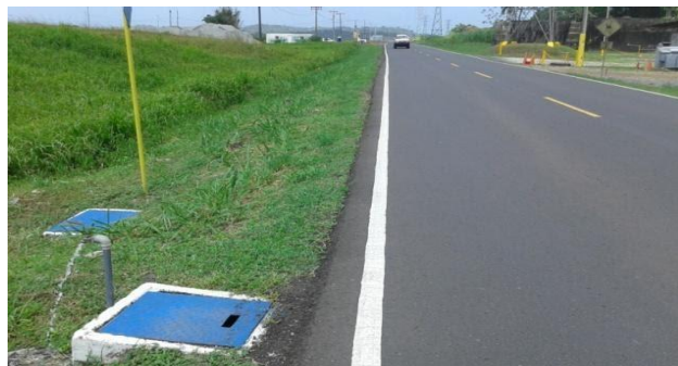
Figura 4 b. Toma de agua – Medidor zona Procesadora (MZPD) y Medidor de Davis (MDAVIS)
