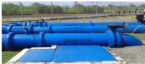
Figura 3 b. Toma de Agua Colón Este (CE), Colón Oeste (CO), Gulick (GUL)
