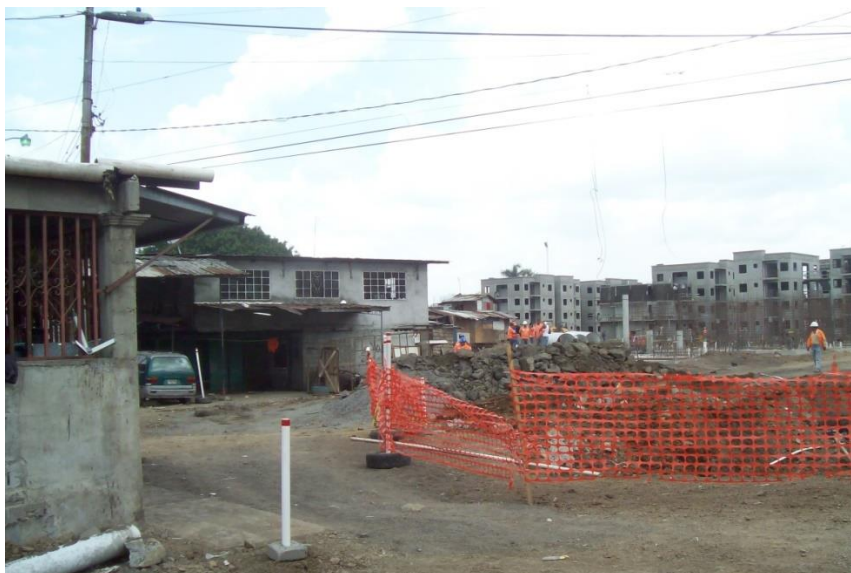
Imagen No.3. Viviendas del Sector El Águila
