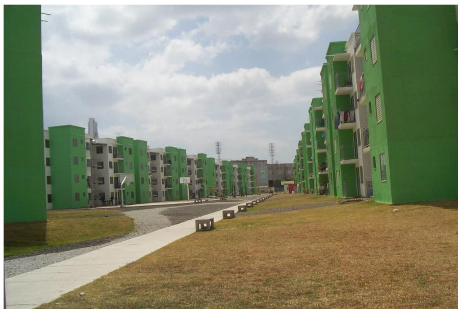
Imagen No.4. Nueva visión del barrio
