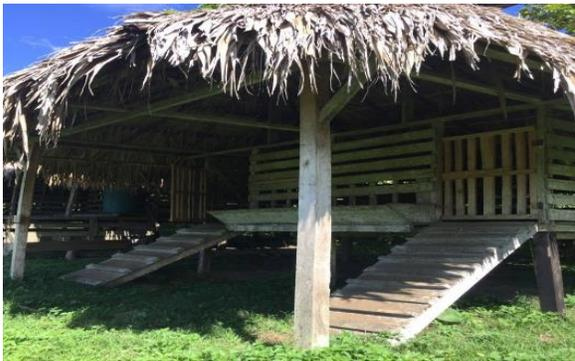
Figura 8. Construcción de rancho para resguardar el ganado. Fuente: fotos tomada por la autora/investigadora
