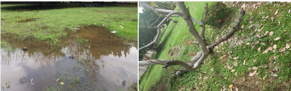
Figura 3a. Suelos inundados por problemas de drenaje, supone producto de la baja atención de las áreas verdes
