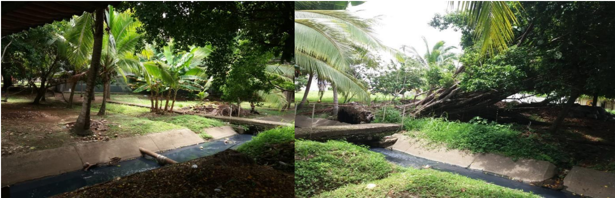
Figura 3c. cuneta de aguas residuales que atraviesa áreas verdes del Centro Regional universitario de Colón
