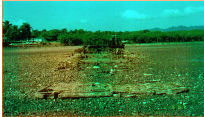
Fig. 2. Restos del ferry varado en la falda de la playa en 1968.
