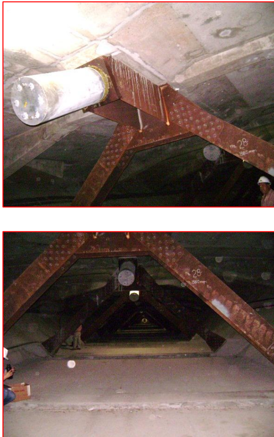
Fig. 2. Marcos con forma de delta (“delta frames”) del Puente Centenario.
